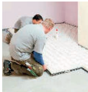
zateplení vnitřních podlah
